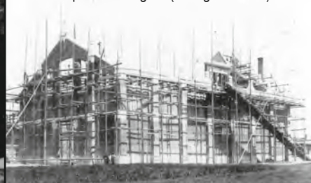
Bau des Spinnerei-Lagers (heutige Kantine)
